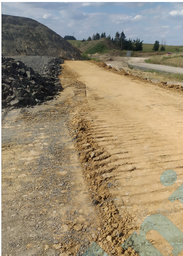
Obrázek 6: Zabudování slínovce do jádra mezi hrázký v km 26,300 z písků (S3 S-F)
