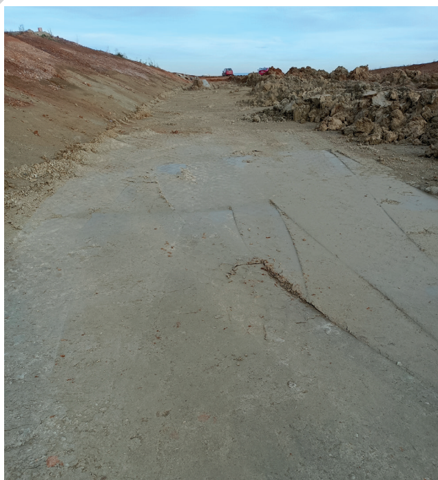
Obrázek 9: Stav parapláňe po měsíčnímu vystavení klimatickým vlivům a přehutnění
