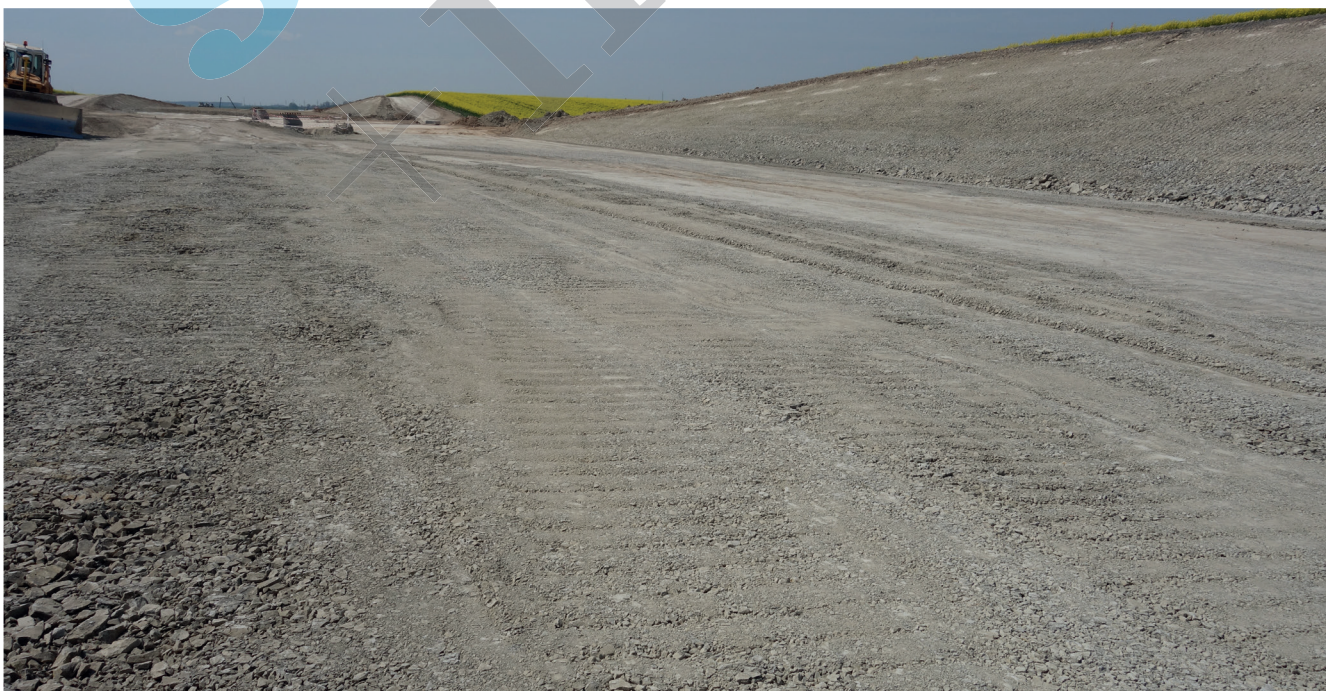
Obrázek 5: Pohled na zářez v km 102,630 až 102,930 po dotěžení na paraplaně
