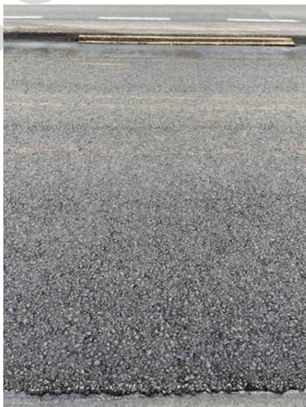
Obrázek 4: Pokládaná asfaltová směs ACL 22S PMB 25/55-60 (PMB 25/55 RC + 35 % RA)
