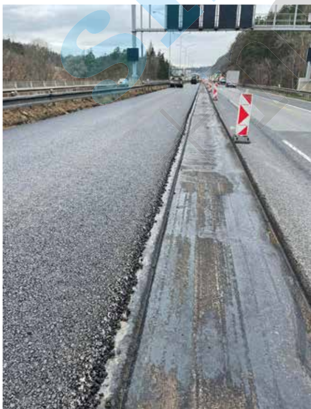
Obrázek 4: Pokládaná asfaltová směs ACL 22S PMB 25/55-60 (PMB 25/55 RC + 35 % RA)
