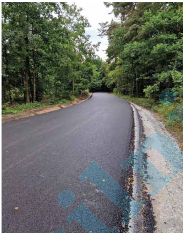
Obrázek 6: ACO 11+ PMB 25/55-60 (PMB 45/80 RC + 35 % RA)
