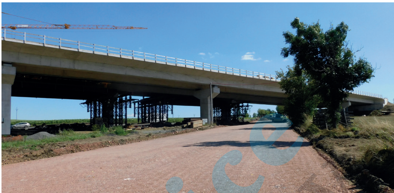
Obrázek 1: Dálnice D4, úsek Milín–Lety, přeložka II/604, materiál z haldy č. 19 (doprovodné horniny z těžby uranových rud) v aktivní zóně a na zemní pláni (11. 8. 2023) (Foto J. Krtek)
