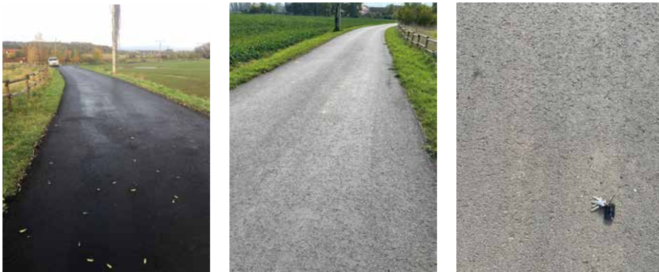
Obrázek 3: Fotky ze zkušebního úseku se směsí ACO 16 s obsahem 80 % RA. Úsek po pokládce (vlevo) a po uplynutí 24 měsíců (uprostřed a vpravo)
