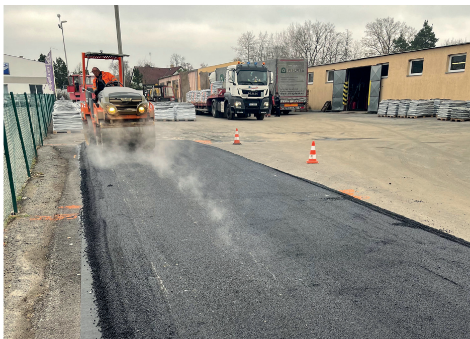
Obrázek 7: Vlevo – hutnění obrusné vrstvy zkušebního úseku v Soběslavi, vpravo – detail na umístění vývrtů (v těsné blízkosti dříve odebraných)
