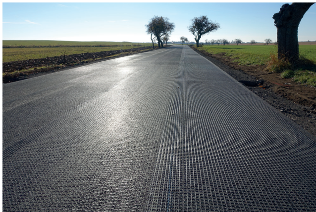
Obrázek 2: Samoadhezní mříž TAV 1 SAM po celoplošné instalaci na vyrovnávací vrstvu před použitím spojovacího postříku
