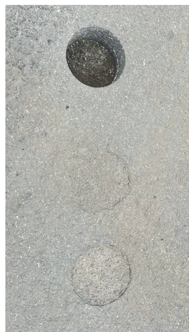
Obrázek 7: Vlevo – hutnění obrusné vrstvy zkušebního úseku v Soběslavi, vpravo – detail na umístění vývrtů (v těsné blízkosti dříve odebraných)
