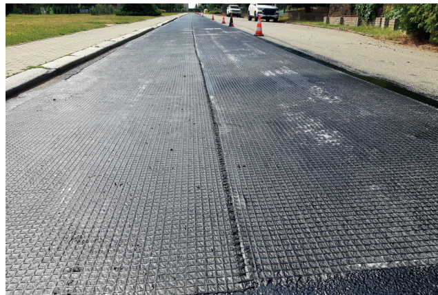
Obrázek 3: Výztužný kompozit TAV 1 ULV po instalaci do nevyštěpeného spojovacího postříku (dávkování 0,3 \text{ kg/m}^2 )
