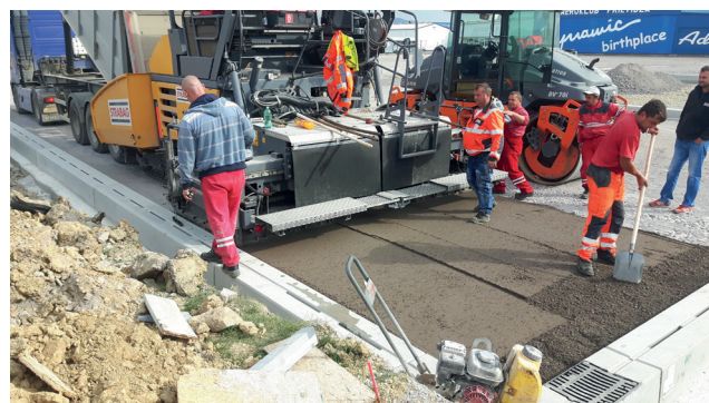
Obrázok 6: Kladenie vrstvy MCSK-TPA (letisko Prievidza)
