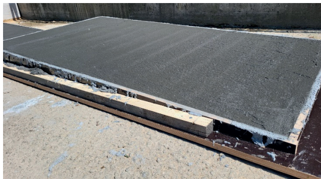
Obrázek 4: Zkouška ukládky UHPC do spádu
