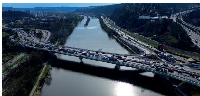
Obrázek 1: Celkový pohled na most (zdroj: Technická správa komunikací hl. m. Prahy, a.s.)
