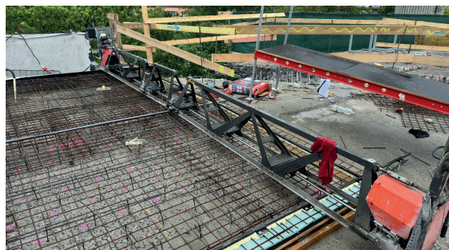
Obrázek 6: Využití mechanizace při ukládce vrstvy z UHPC
